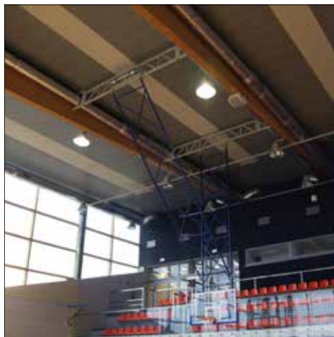
Konstrukcja montowana pomiędzy dźwigarami
