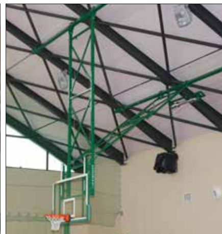
Konstrukcja mocowana do dachu skośnego
