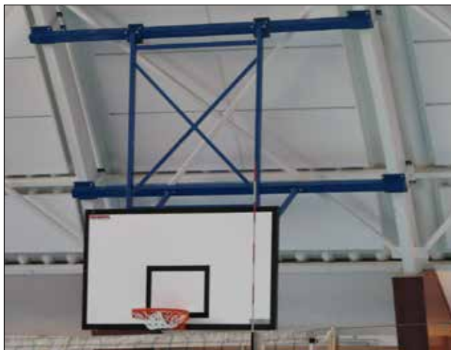
Konstrukcja specjalna, montowana do konstrukcji dachu
