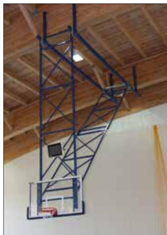
Montaż do dźwigara drewnianego
