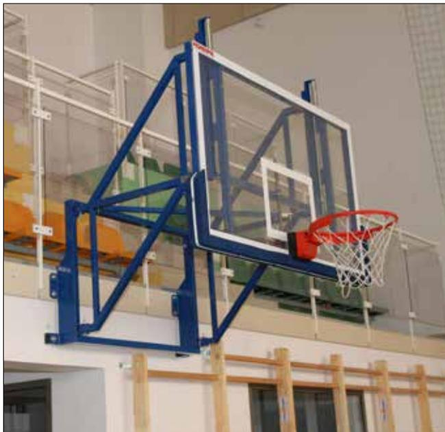
Наклонная конструкция, крепление к балкону
